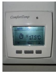
Figur 8 – Regulator til varmekabel
