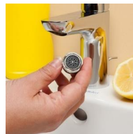
Figur 7 – eksempel sil på blandebatteri
