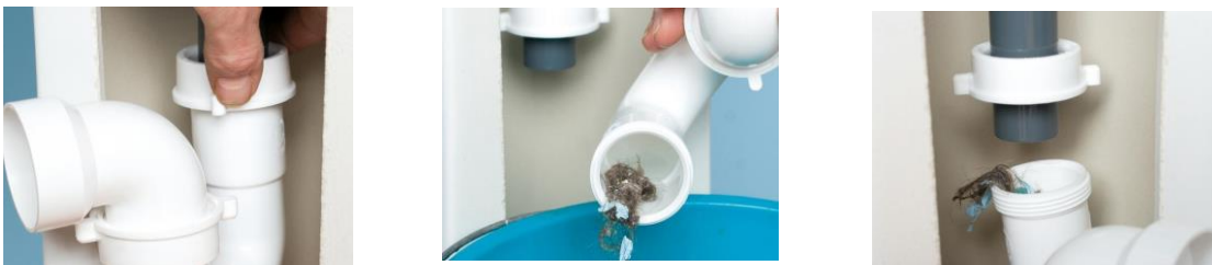
Figur 6. rens av vannlås
