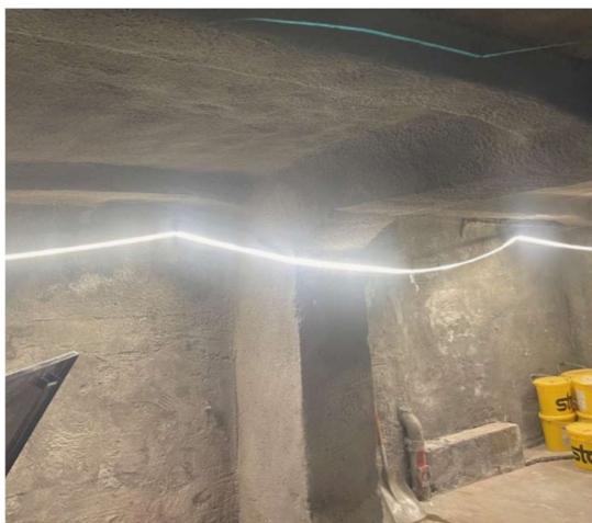
Figur 3Bilde etter støpning klar til overflatebehandling
