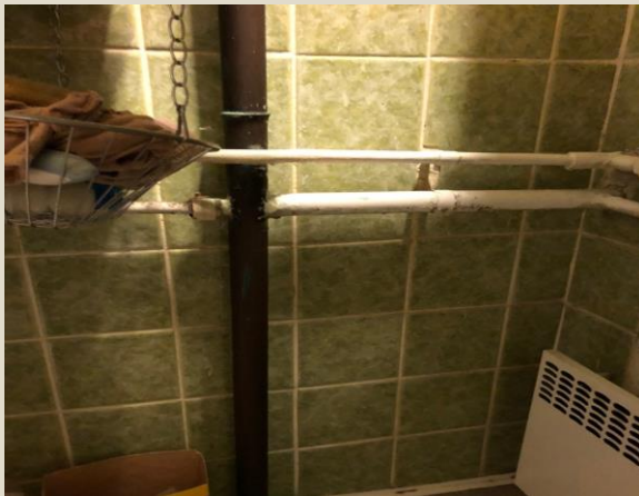
Eldre rørføringer bad
